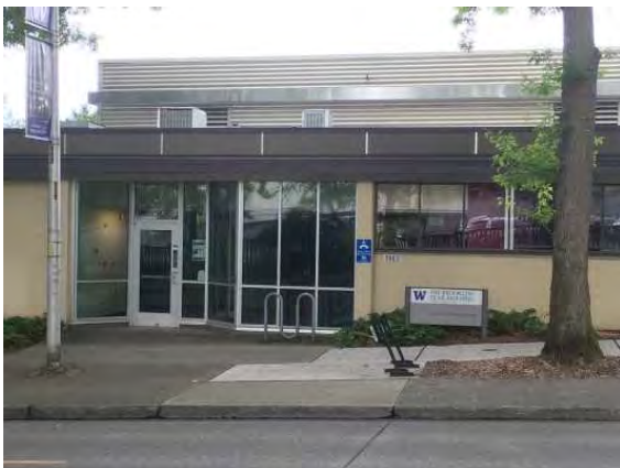
Brooklyn Trail Bldg_1115_2.jpg
