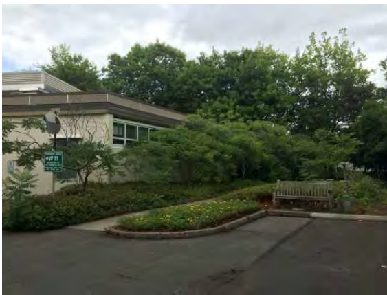
Brooklyn Trail Bldg_1115_4.jpg
