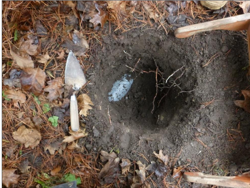
Figure 7-6. Electrical conduit in SP5.
